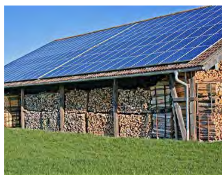
Il est possible de produire de l'énergie sur un bâtiment isolé pour une communauté de consommation.
