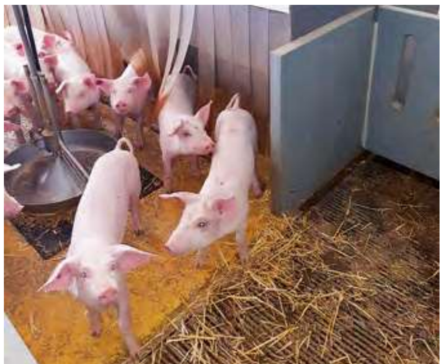
En mise bas et post-sevrage, le programme Prokilowatt de l'OFEN soutient la conversion des caisses à porcelets à chauffage électrique en systèmes économes en énergie. Photo: AgroCleanTech
