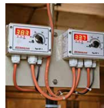
La température est mesurée en continu et adaptée automatiquement.
